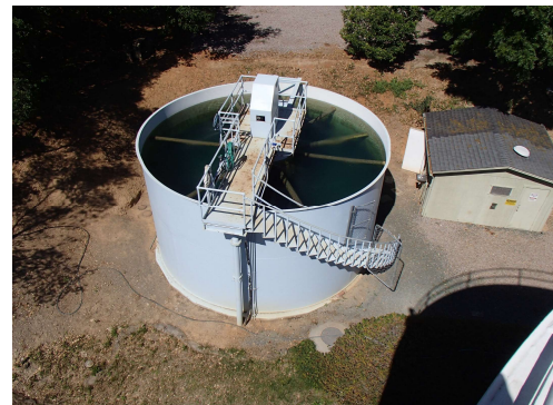
Koagulationsmittel für die Sedimentation im Tank
