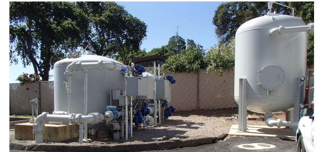
2 Druckfilter (Anthrazit und Sand) laufen parallel
